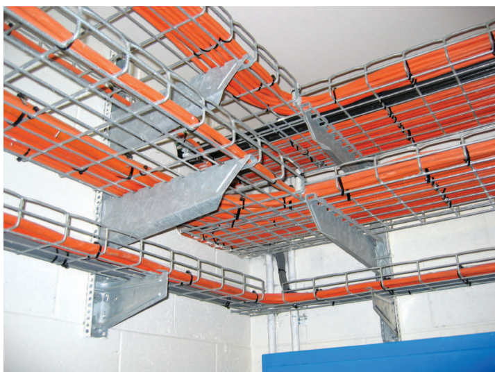
Przykładowe rozmieszczenie instalacji z kabli w korytkach kablowych
